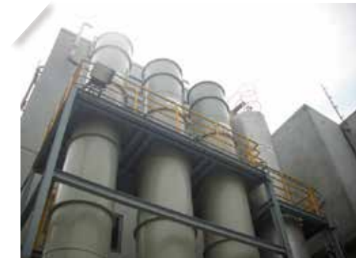
空污煙道照片
