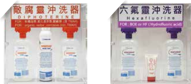
六氟靈及敵腐靈藥劑設置
